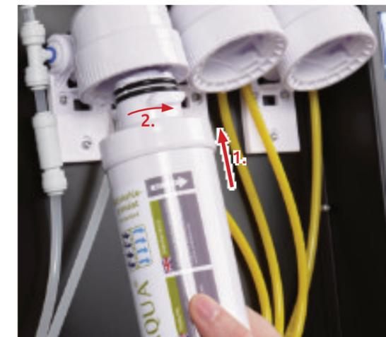
Setzen Sie die neue Filterkartusche in den Filterkopf ein und drehen Sie dabei die Filterkartusche um 90° im Uhrzeigersinn.
