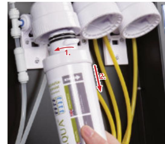
Drehen Sie Filterkartusche um 90° gegen den Uhrzeigersinn aus dem Filterkopf heraus, um die Filtereinheit zu wechseln.
