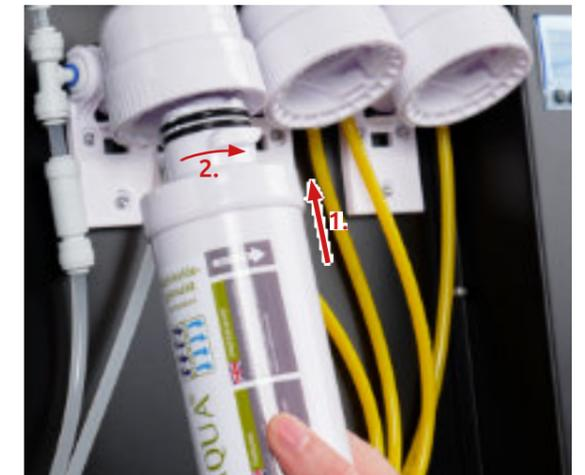
Setzen Sie die neue Filterkartusche in den Filterkopf ein und drehen Sie dabei die Filterkartusche um 90° im Uhrzeigersinn.
