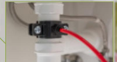
Rotes 1/4" Rohr für das Abwasser am Siphon - **max. 2 m**
