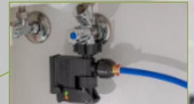
Blaues 3/8" Rohr für die Wasserzufuhr am Eckventil
