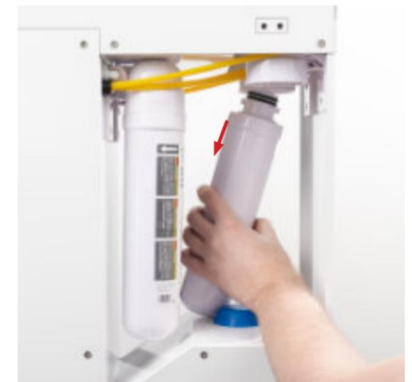
Nun können Sie die Filterkartusche aus dem Filterkopf herausnehmen. Die neuen Vorfilter installieren Sie in umgekehrter Reihenfolge.
